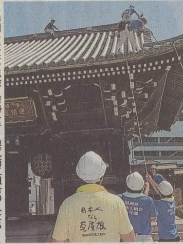
楼門の屋根の点検と清掃を行う県瓦商工組合の人たち
