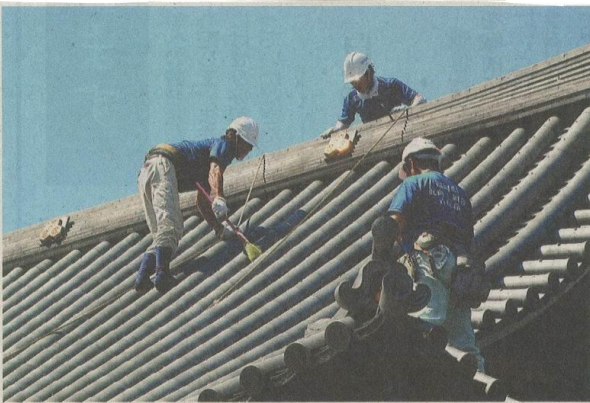
急勾配の楼門の屋根に上り、瓦を点検する職人たち
